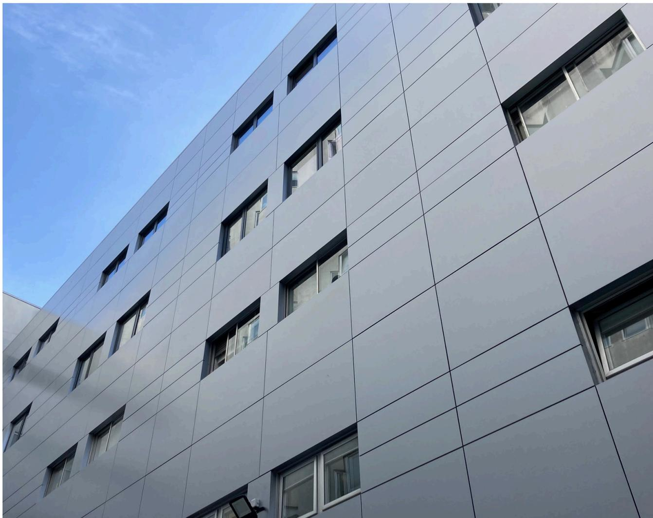
*Se trata de un sistema constructivo de cerramiento exterior multicapa que nos permite aislar el edificio por el exterior, de forma continua, evitando así los puentes térmicos y las condensaciones.*
